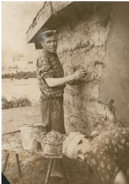
1944 г. Иоган Рунде и своячница Мария Рунде при строительстве саманного дома
